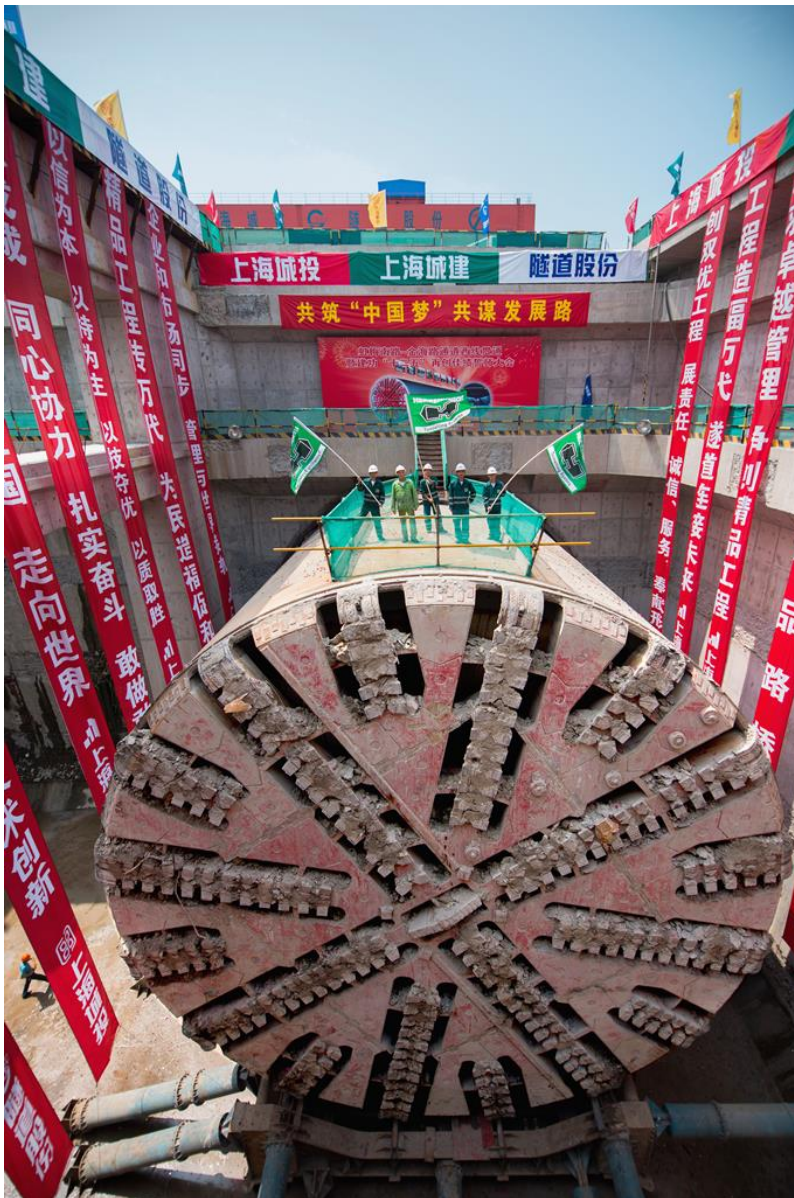
Bild 4: Erstes Ziel erreicht: Zwischendurchbruch der Herrenknecht Mixschild S-666 ( \varnothing 14,900mm) für den Shanghai Hong Mei Straßentunnel am 8. Juli 2013.
